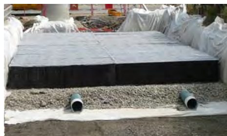
Photo 3.2 : Exemple de SAUL à diffuseur externe
