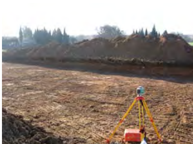
Terrassement et nivellement du fond de fouille
