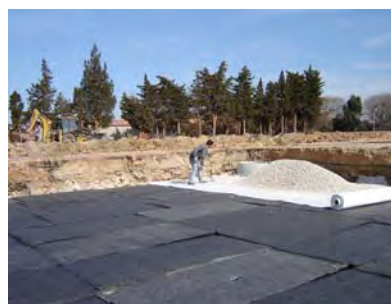
Mise en œuvre du remblai initial sur géotextile (couche de ventilation)
