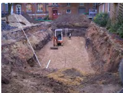
Terrassement et nivellement du fond de forme
