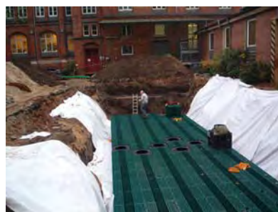
Mise en œuvre et assemblage des SAUL sur géotextile (1)
