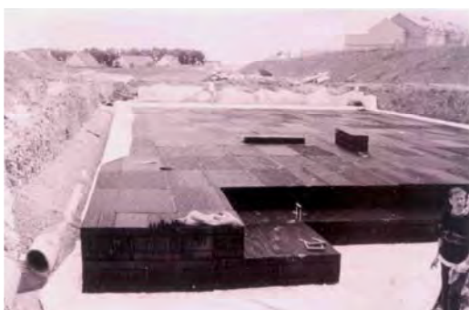
Photo 2.5 : Réalisation d'un bassin enterré...
