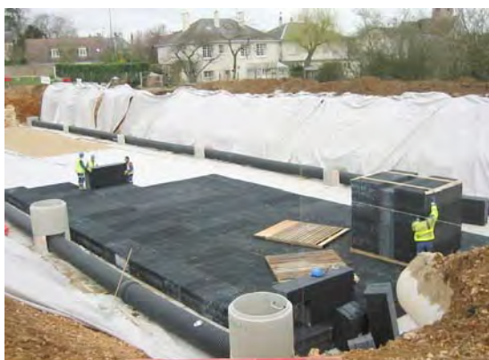
Photo 3.6 : Exemple de réalisation d'un réseau de drainage latéral
