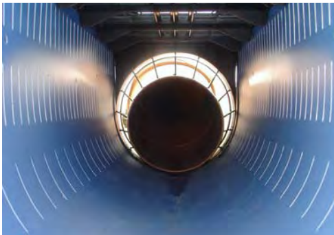
Photo 7.1 : Exemple de canal de diffusion équipé d'une paroi diffusante
