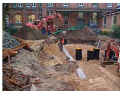
Mise en œuvre des remblais latéral, initial et supérieur
