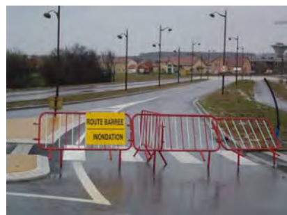
Photo 1.2 : Voirie submergée par des eaux de ruissellement
