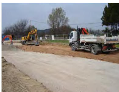
Mise en œuvre du remblai supérieur
