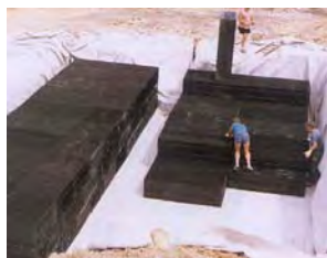
Photo 2.2 : Mise en œuvre de SAUL en nid d'abeilles
