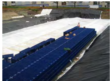
Photo 5.1 : Exemple de mise en œuvre de SAUL
