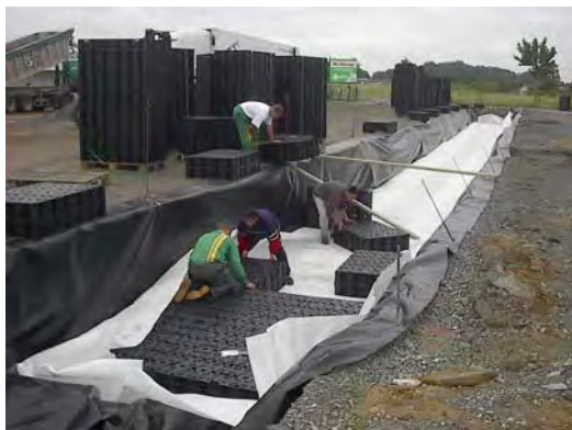
Photo 3.9 : Pose de modules de SAUL sur une géomembrane protégée par un géotextile
