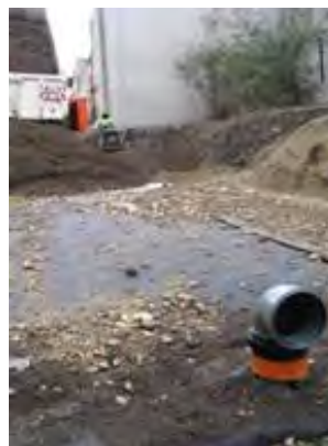
Photo 3.8 : Exemple de ventilation connectée à un regard
