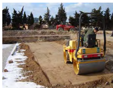
Compactage du remblai supérieur
