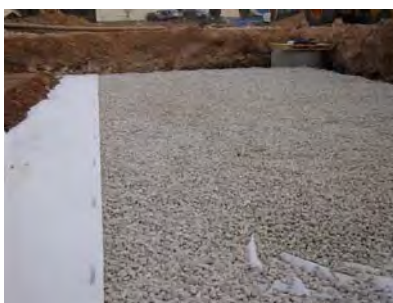
Achèvement du remblai initial
