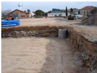
Préparation du fond de forme
