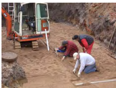
Préparation du lit de pose
