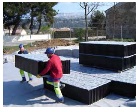
Photo 2.4 : Une mise en œuvre aisée et rapide
